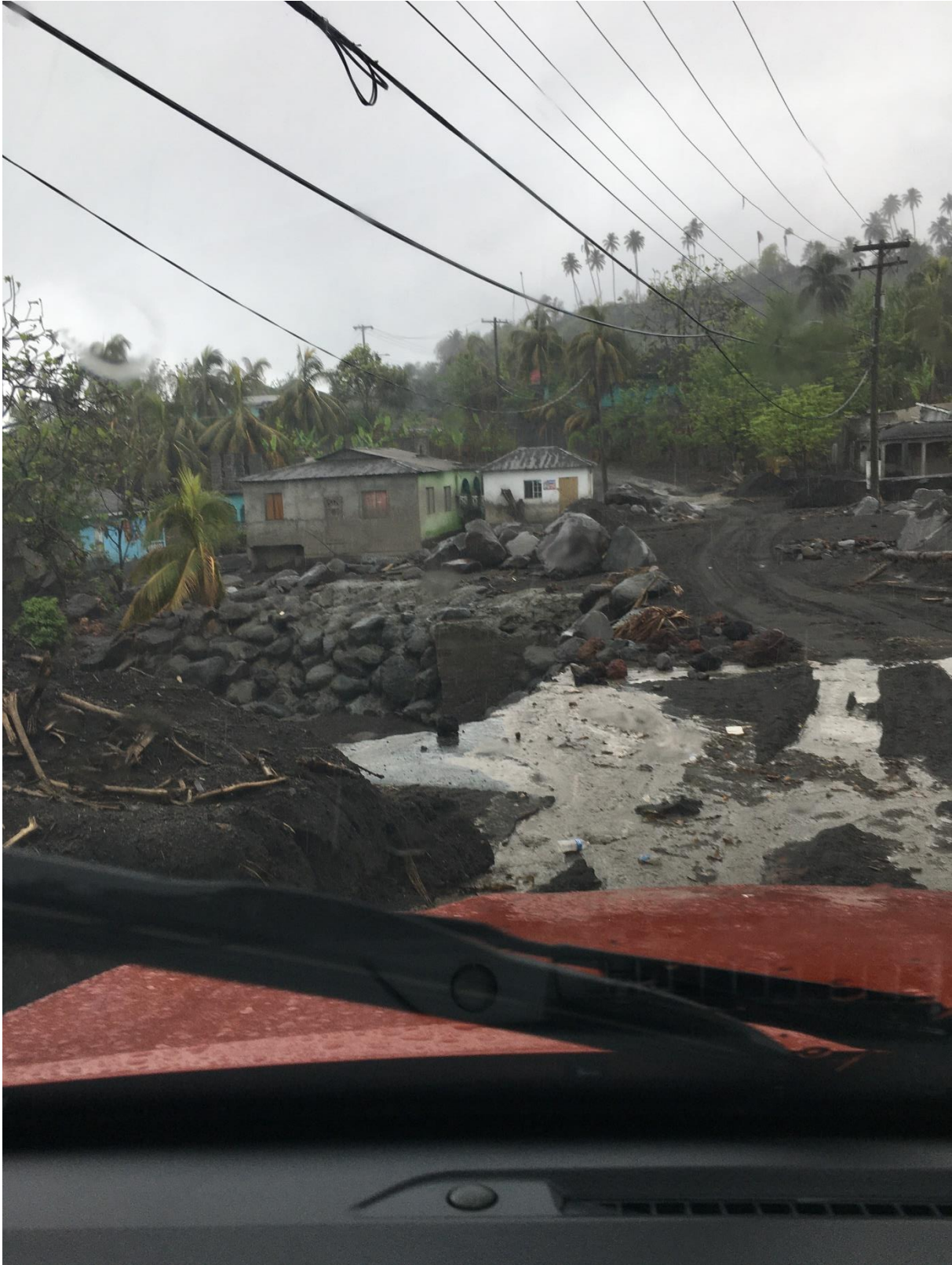
Ausgewaschene Straßen und durch Lahars mitgerissene Felsbrocken
